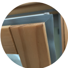
Guarnizione perimetrale del battente saldata agli angoli
