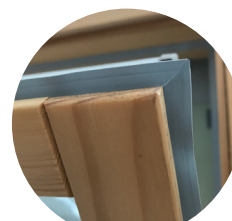
Guarnizioni perimetrali del battente saldate agli angoli
