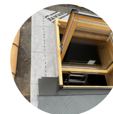
Collare impermeabilizzante installato. Protegge dalle condense esterne e assicura maggiore longevità al serramento.
